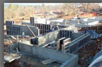
Mise en place des banches
