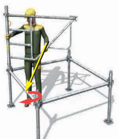
2 - Depuis l'intérieur de la tour, pose du 1 er cadre dans l'axe de la diagonale puis rotation pour le verrouiller.
