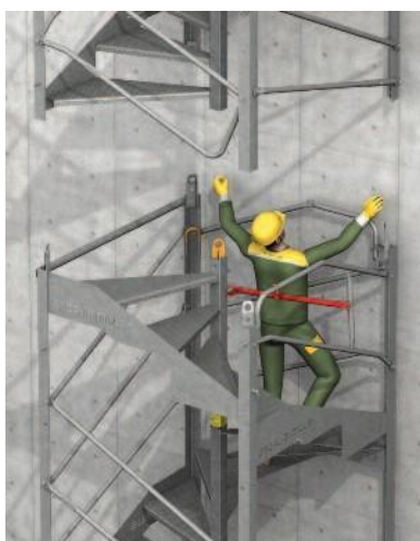
Pose ou dépose d'un module
