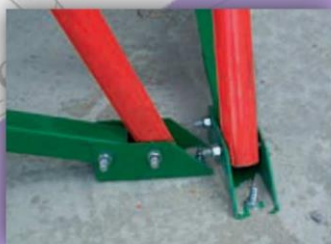
Ancrage sur dalle du sabot de béquille
