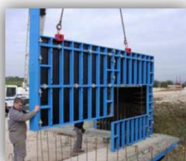
Mise en place des banches
