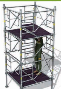
9 - Déplacement du 2 e plancher à trappe depuis le niveau inférieur.
